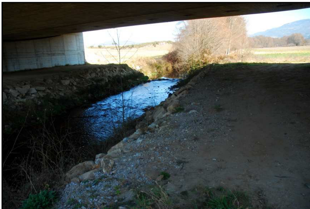
Figura 4.2 – Fragmentação da galeria ripícola sob o viaduto.
