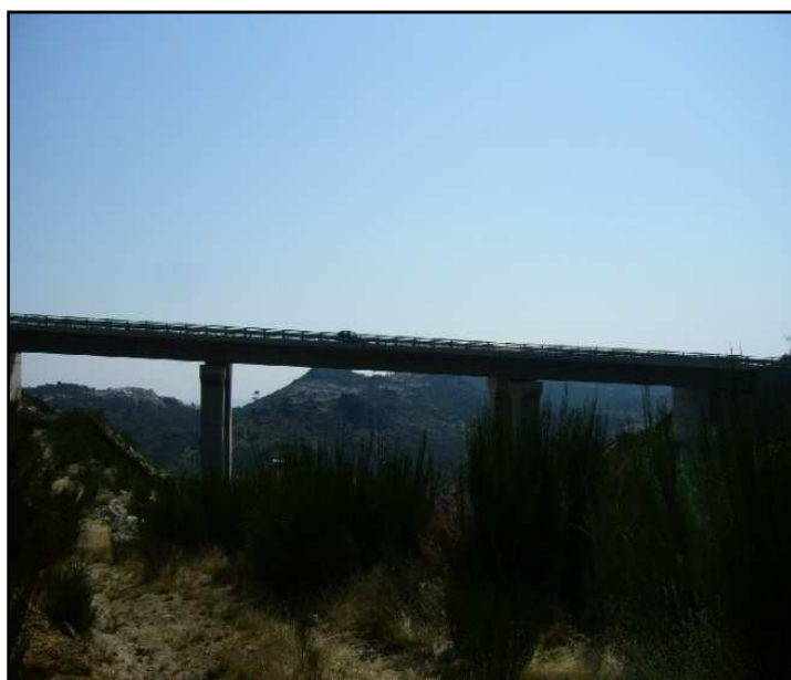
Figura AII.6 – Ponto P6, Viaduto 4.
