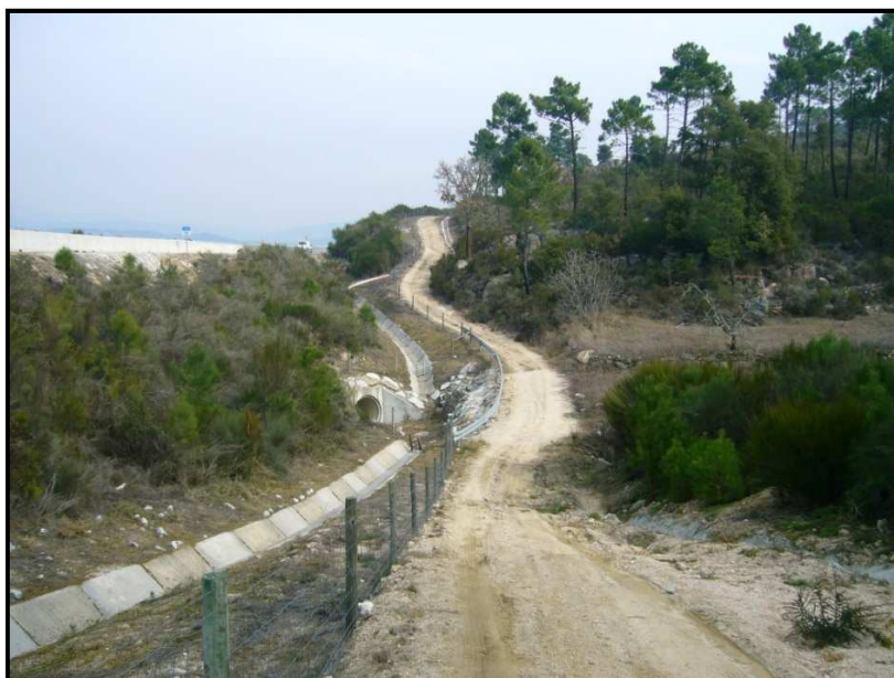
Figura AII.2 – Ponto A2, Capeludos (atravessamento de linha de água).
