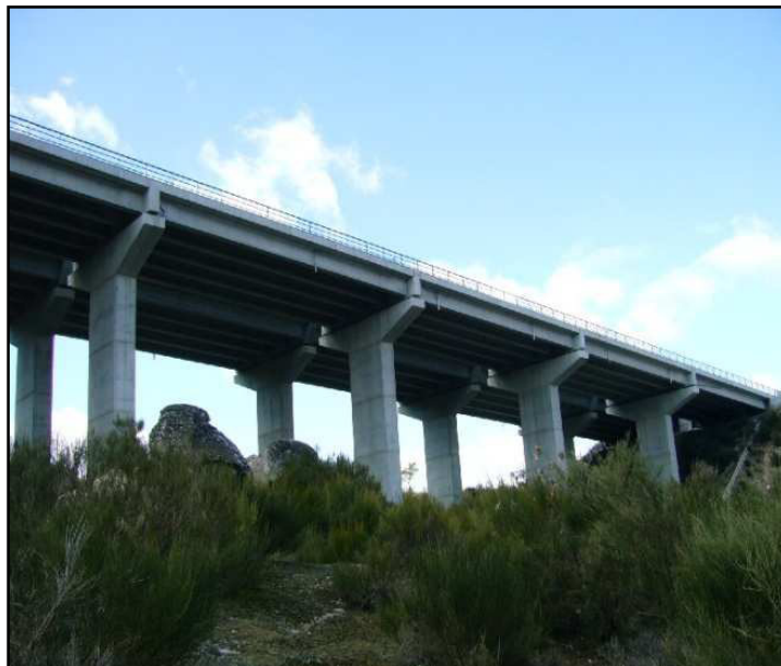
Figura AII.1 – Ponto P1, Viaduto 1.
