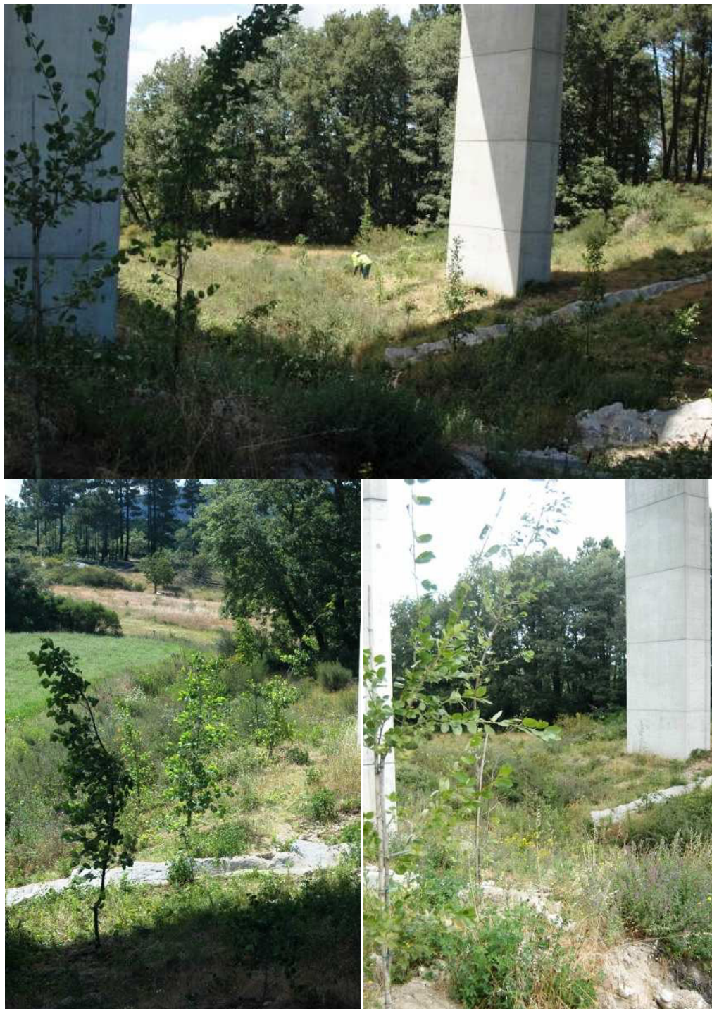
Figura 4.20 – Plantação pela Operscut de Alnus glutinosa e Salix atrocinerea na área de fragmentação da galeria ripícola, sob o Viaduto do Caneiro.
