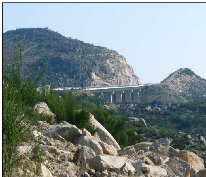
Figura AII.7 – Ponto P7, Viaduto 5.
