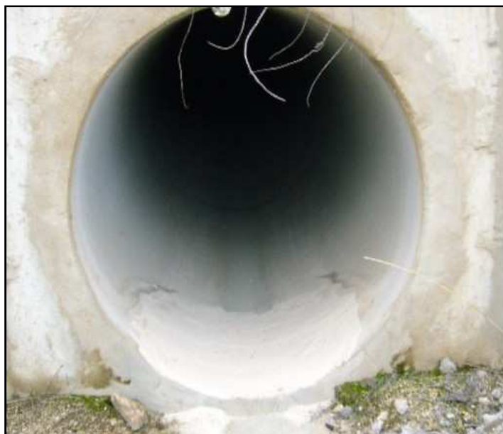
Figura 3.2 – Detalhe de uma passagem hidráulica, preparada com pó de pedra para a detecção de vertebrados.
